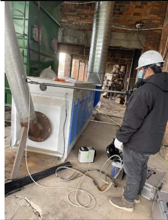
活性炭吸附装置进口采样照片
