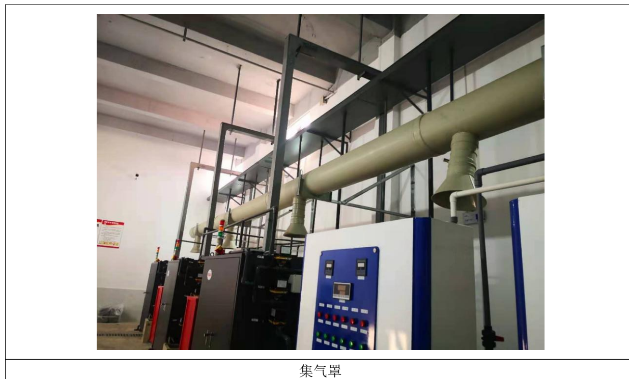
图 4.1-2 项目废气处理设施照片
